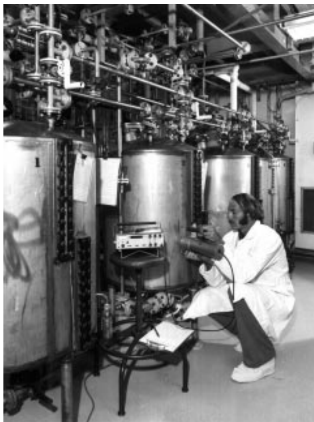
Рис. 20.6. Пример использования коллимированного детектора NaI и портативного блока электроники для измерения отложений в резервуарах, заполненных кольцами Рашига
